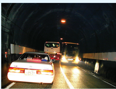
国道158号線奈川渡ダム下流2.2kmのトンネル内の狭隘ヶ所
